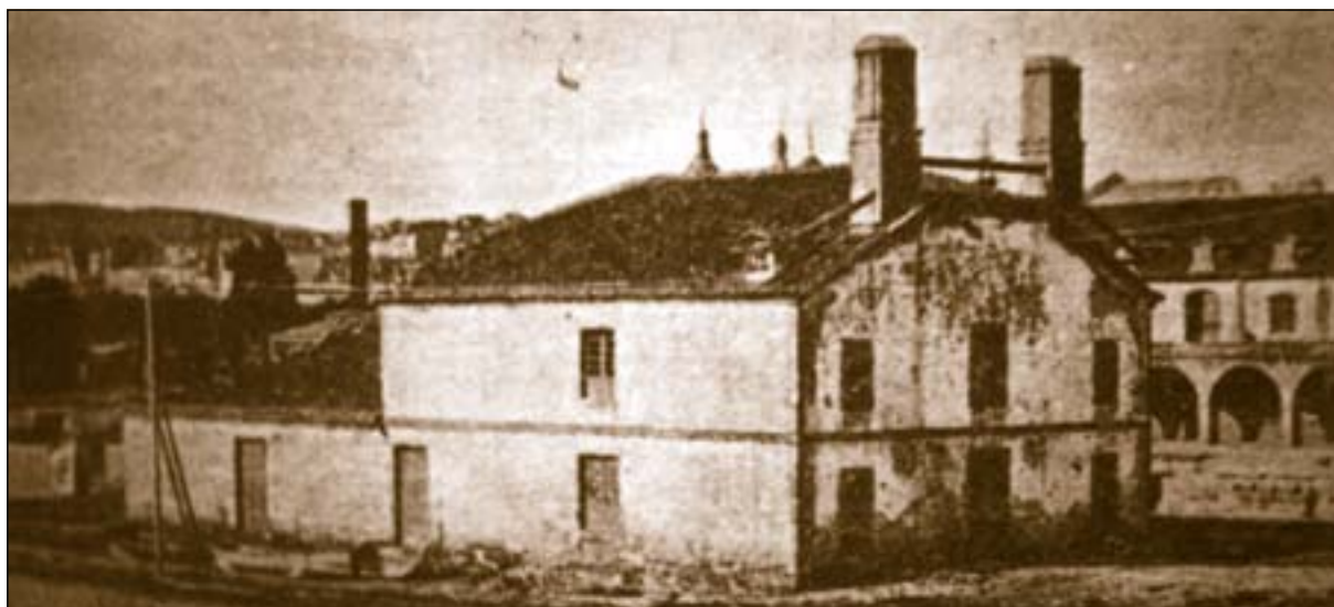
Fotografía de la Casa de Bombas en 1899. Obsérvese el edificio de doble cuerpo que albergaba la casa de bombas.
